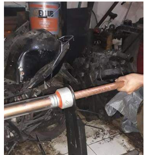
Imagen 10 y 11. Desmontaje del tubo
